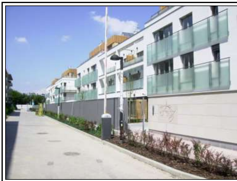
2009 - „Feliz Residence”, Warszawa, ul. Przy Parku 22, 40 mieszkań, inwestor: Viterra Development Polska Sp. z o.o., kierownik projektu, inspektor nadzoru, nadzór inwestorski (wszystkie branże) - MIKOB
