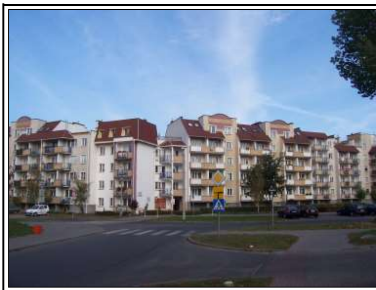
1996 - Toruń, Koniuchy, 60 mieszkań, inwestor: BUDLEX Sp. z o.o., kierownik robót BUDLEX
