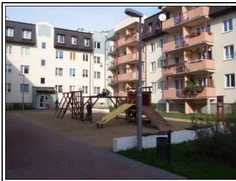
2005 - Toruń, ul. Olsztyńska, 54 mieszkania, inwestor: BUDLEX Sp. z o.o., kierownik budowy MIKOB (we współpracy z BUDLEX)
