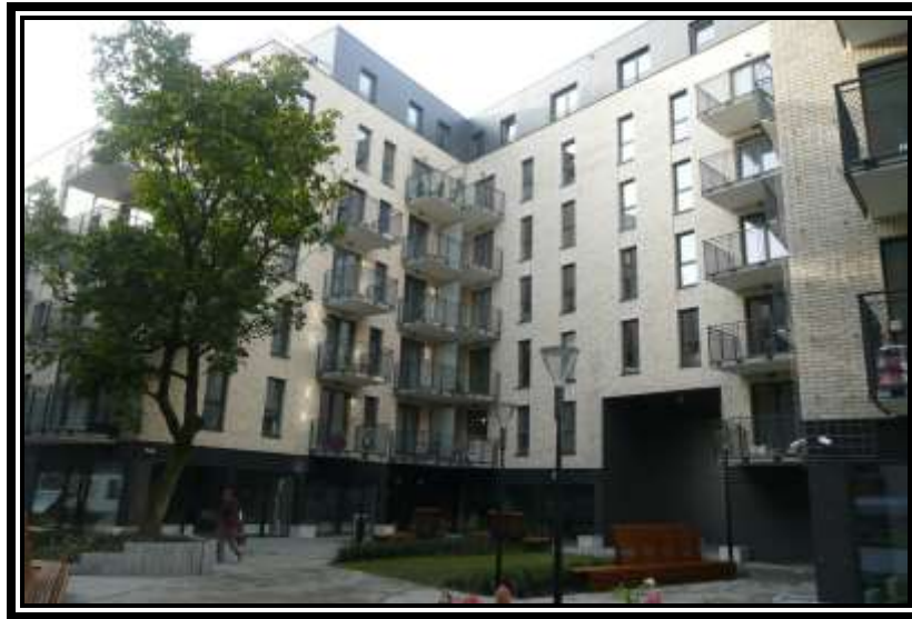
2018 - 2020 - „Stalowa 39”, Warszawa, ul. Stalowa / Strzelecka, 202 lokale mieszkalne, 16 lokali usługowych, inwestor: Bouygues Immobilier Polska Sp. z o.o., Inwestor Zastępczy - MIKOB
