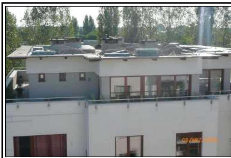
2009 - „Osiedle Wichrowy Park”, Warszawa, ul. Wichrowa 7, 7 A-F, prace remontowe, inwestor: Viterra Development Polska Sp. z o.o., inspektor nadzoru - MIKOB
