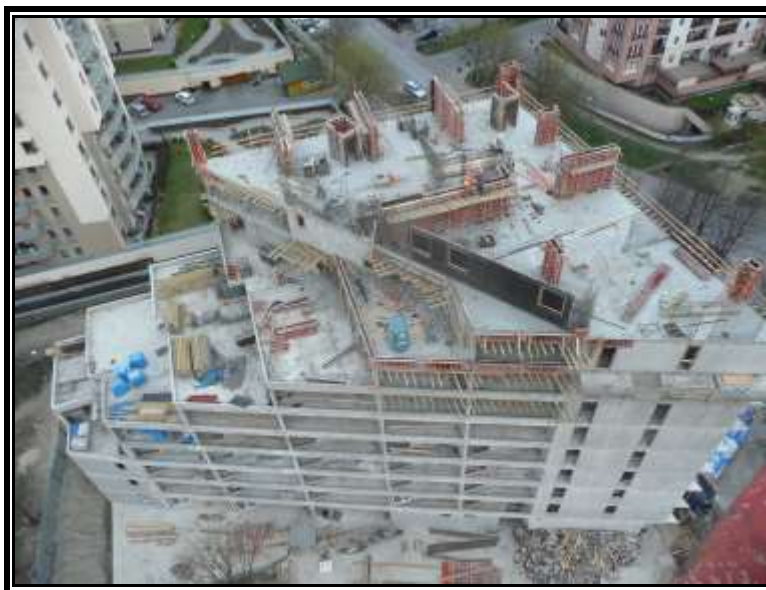
2012 - 2014 - „La Cascade”, Warszawa, ul. Bogusławskiego 17, 109 mieszkań, inwestor: Bouygues Immobilier Polska Sp. z o.o., Inwestor Zastępczy - MIKOB
