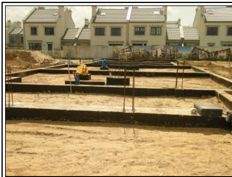
2010 - 2016 - Le Village, Piaseczno - Józefostaw, osiedle 233 domów jednorodzinnych z infrastrukturą, inwestor: Bouygues Immobilier Polska Sp. z o.o., Zarządzający - MIKOB
