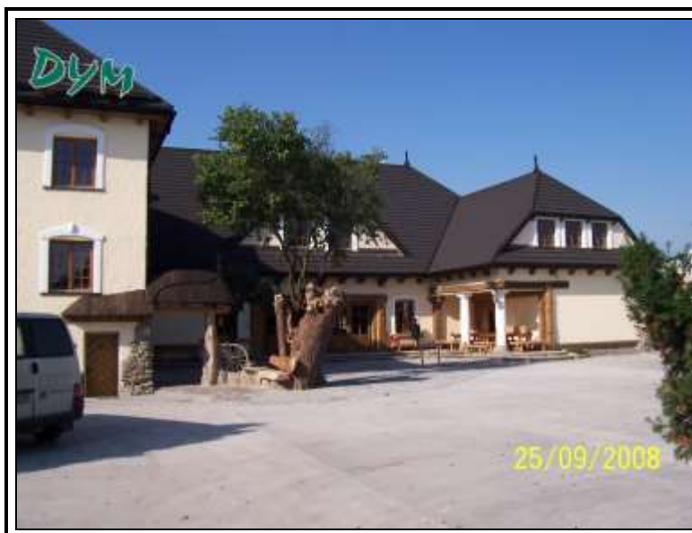
2008 - Restauracja z częścią mieszkalną „SIWY DYM”, Warszawa, ul. Puławska 378, inwestor prywatny, kierownik budowy - MIKOB
