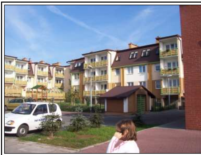
2003 - Toruń, ul. Chabrowa, 50 mieszkań, inwestor: BUDLEX Sp. z o.o., funkcja - kierownik budowy BUDLEX
