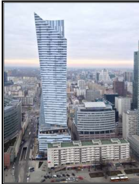
2009 - 2010 - „Złota 44”, Warszawa, ul. Złota 44, projekt Daniela Libeskinda, inwestor: ORCO Property Group Sp. z o.o., inspektor nadzoru w branży konstrukcyjno- budowlanej - MIKOB
