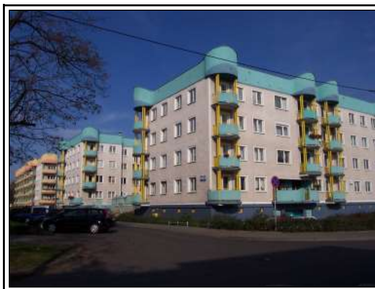
2000 - Toruń, ul. Bartkiewiczówny, 120 mieszkań, inwestor: BUDLEX Sp. z o.o., kierownik budowy BUDLEX
